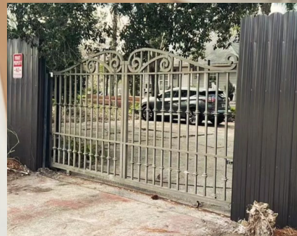
PUERTAS Y SOLDADURAS
